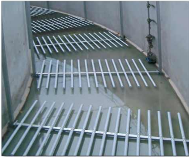
Vydvíhovatelné systémy umožňují údržbu za provozu.
