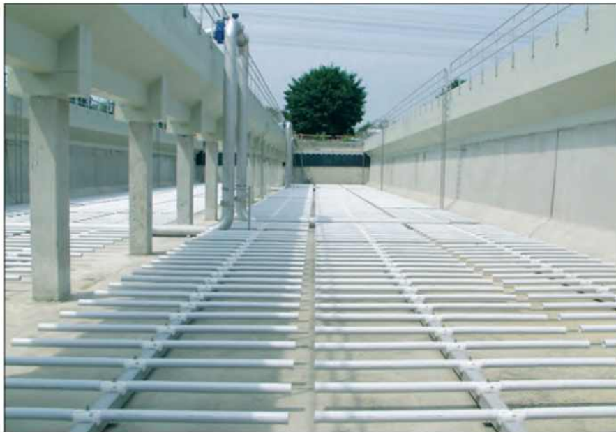
Трубчатые аэраторы MAGNUM® 2000 FLEXSIL® в аэротенке Аэрационные системы фирмы OTT – в сравнении.
