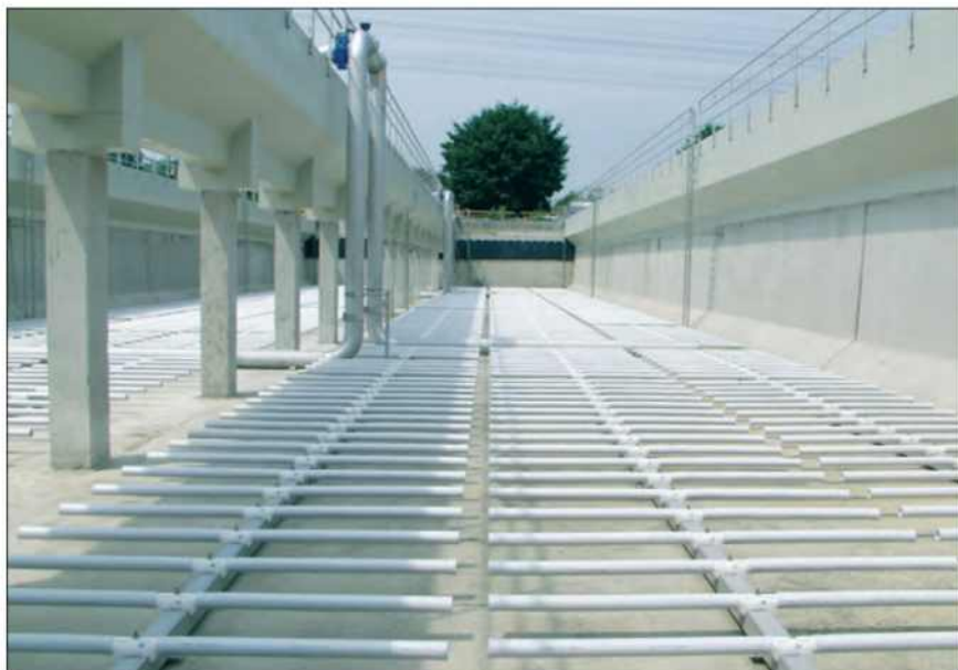
Provzdušňovací nádrž s membránovými provzdušňovací potrubí MAGNUM® 2000 FLEXSIL®
