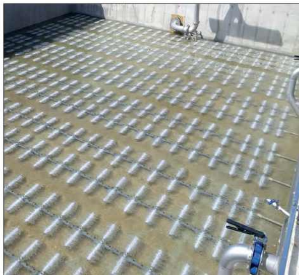
OTT provzdušňovací systém s rozdělovači AirRex®
